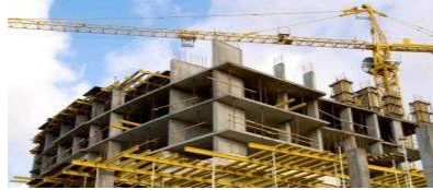
Figura 14. Construcción de edificio
