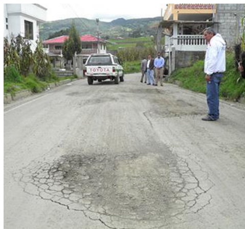
Figura 18. Hundimiento
