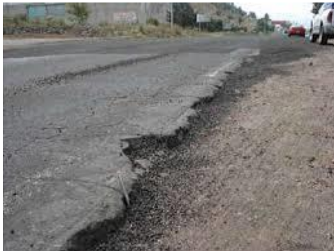
Figura 20. Desintegración de bordes
