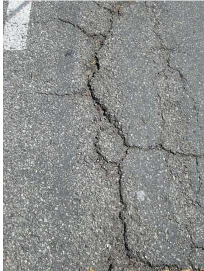
Figura 12. Fisura longitudinal
