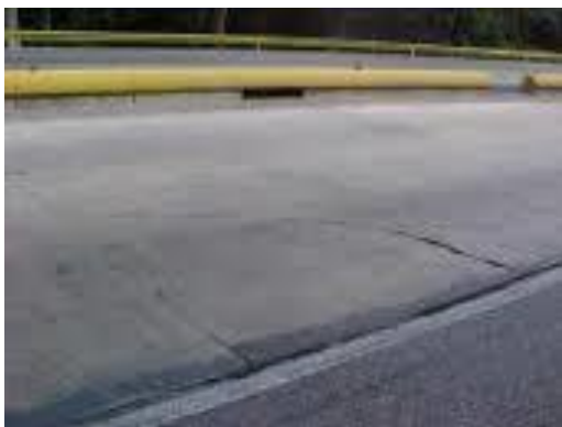
Figura 13. Reflexión en junta
