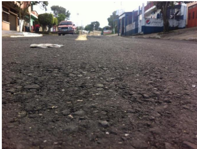
Figura 21. Exposición de agregados
