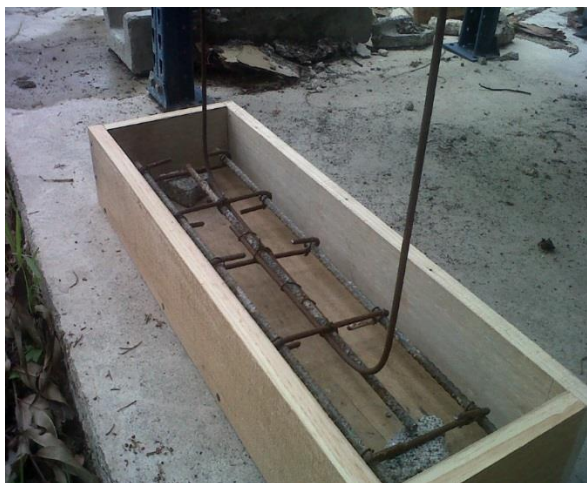
Figura 1. Armado y formateado del cemento del prisma
