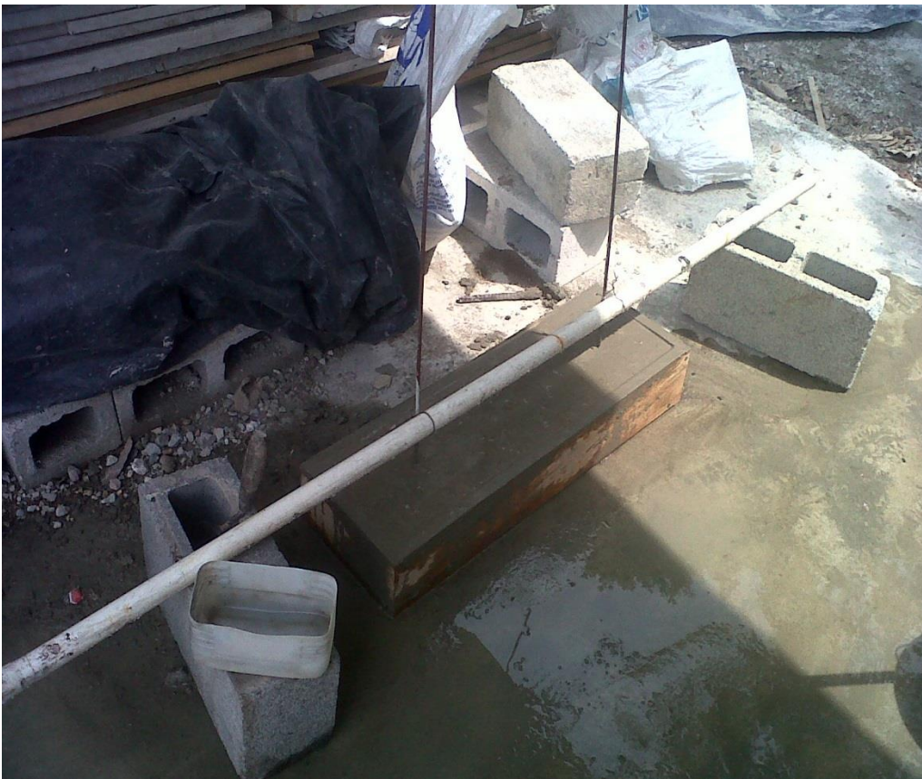
Figura 2. Fundición del cimiento del prisma
