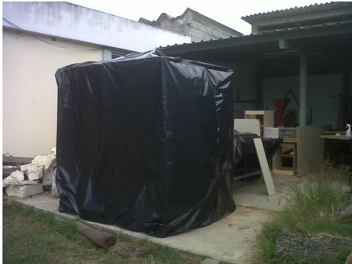
Figura 28. Cámara de curado tipo invernadero
