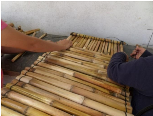
Figura 40. Armado de capa adicional en panel
