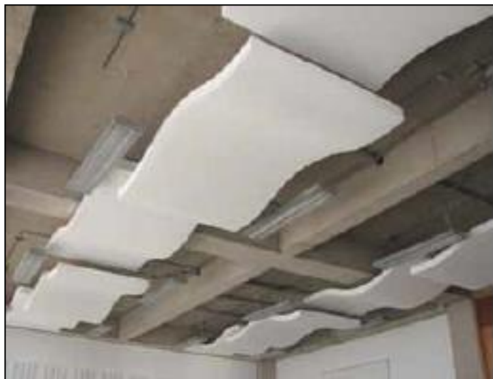
Figura 15. Cielo falso tipo isla
