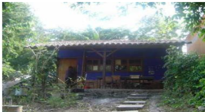
Figura 5. Casa de bajareque
