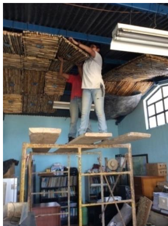
Figura 43. Colocación de paneles utilizando un andamio
