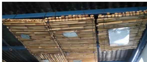
Figura 44. Colocación de trozos de metal en paneles para medición superficial por transferencia de calor
