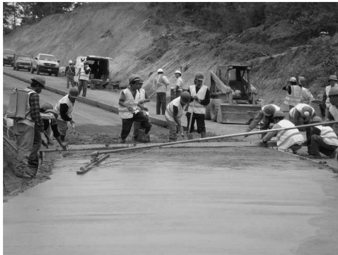
Figura 9. Descarga directa de concreto
