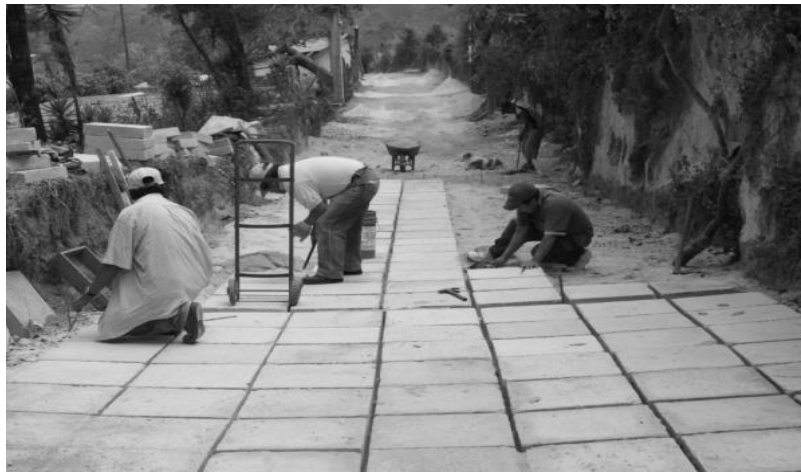
Figura 15. Instalación de bloques en aldea El Aguacate
