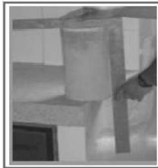
Figura 18. Chequeo de la perpendicularidad
