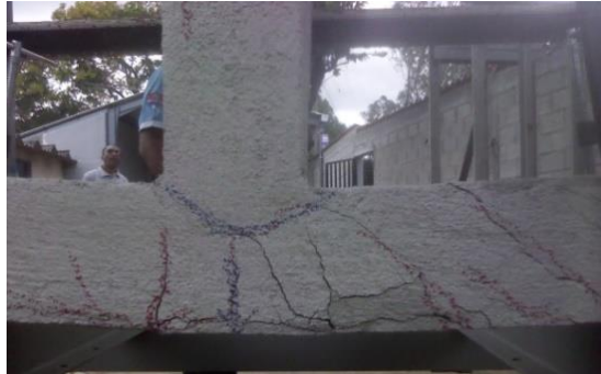
Figura 39. Observación de fallas
