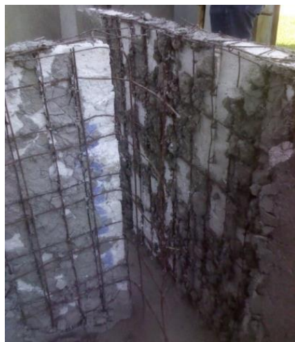
Figura 40. Verificación de armado
