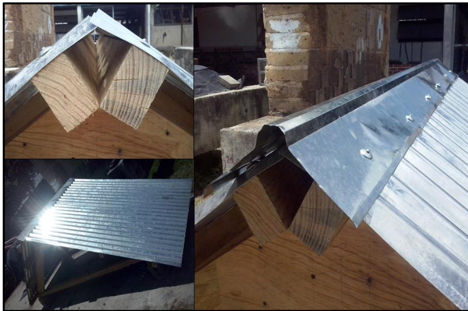
Figura 98. Colocación de lámina galvanizada y capote
