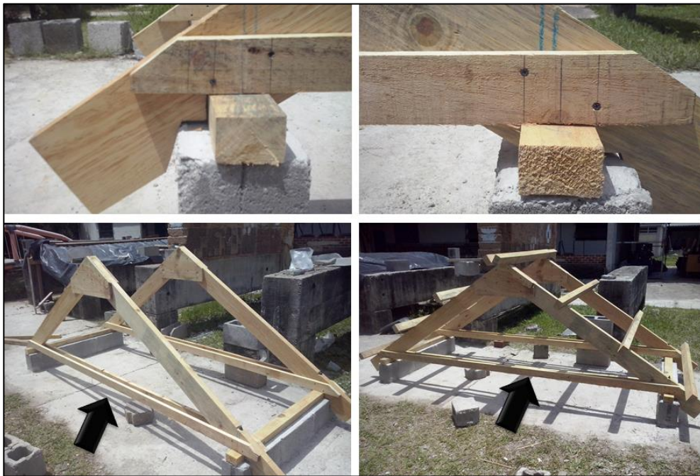
Figura 97. Tensores de madera para tijerones
