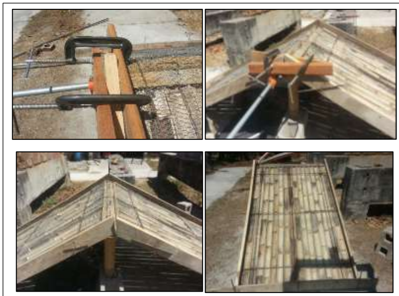
Figura 34. Preparación y colocación de formaletas
