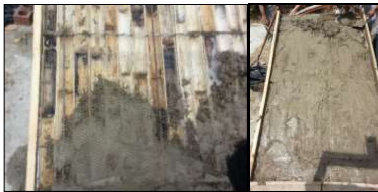
Figura 35. Colocación del mortero
