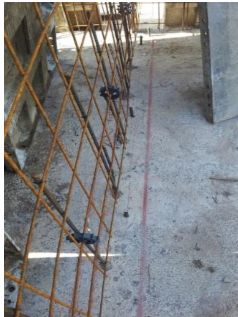
Figura 6. Colocación de electro malla para muros
