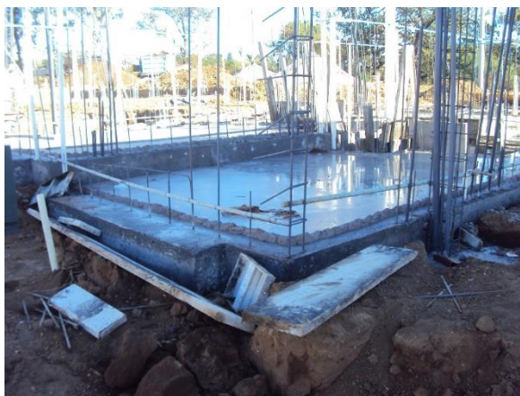
Figura 5. Losa de cimentación acabada
