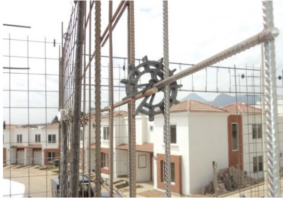
Figura 7. Colocación de separadores de muro
