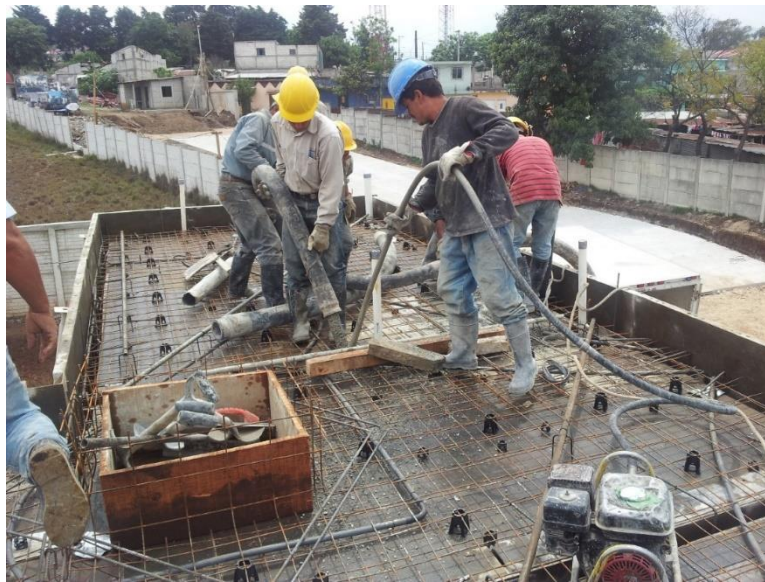
Figura 13. Colocación de concreto
