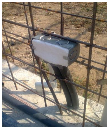
Figura 8. Colocación de instalaciones en muro
