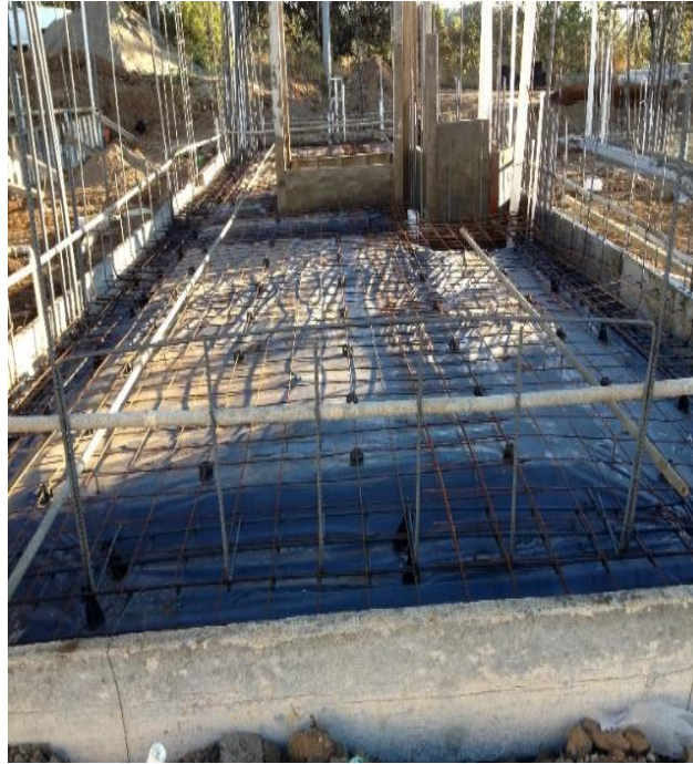
Figura 3. Armado de cimentación
