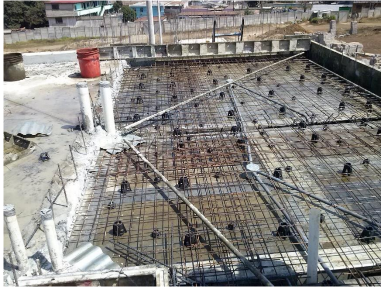
Figura 12. Instalación de electromalla en losa
