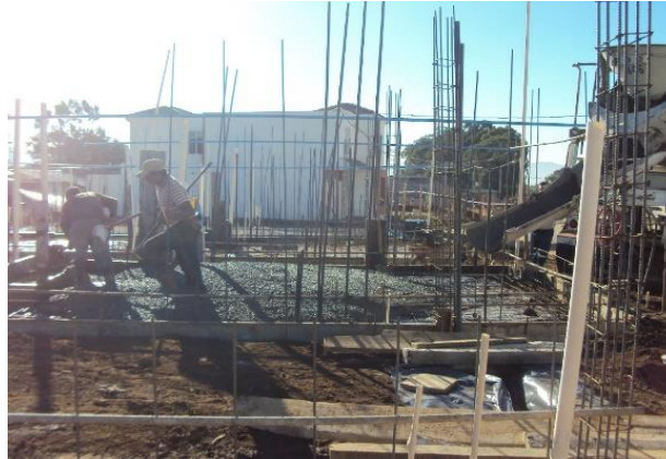
Figura 4. Fundición de losa de cimentación
