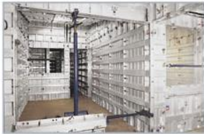
Figura 10. Instalación de paneles
