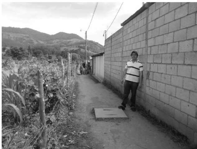
Figura 7. Tanque de distribución aldea Rancho Alegre
