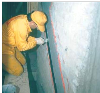
Figura 27. Pegado de placas de acero, Suiza, 1997
