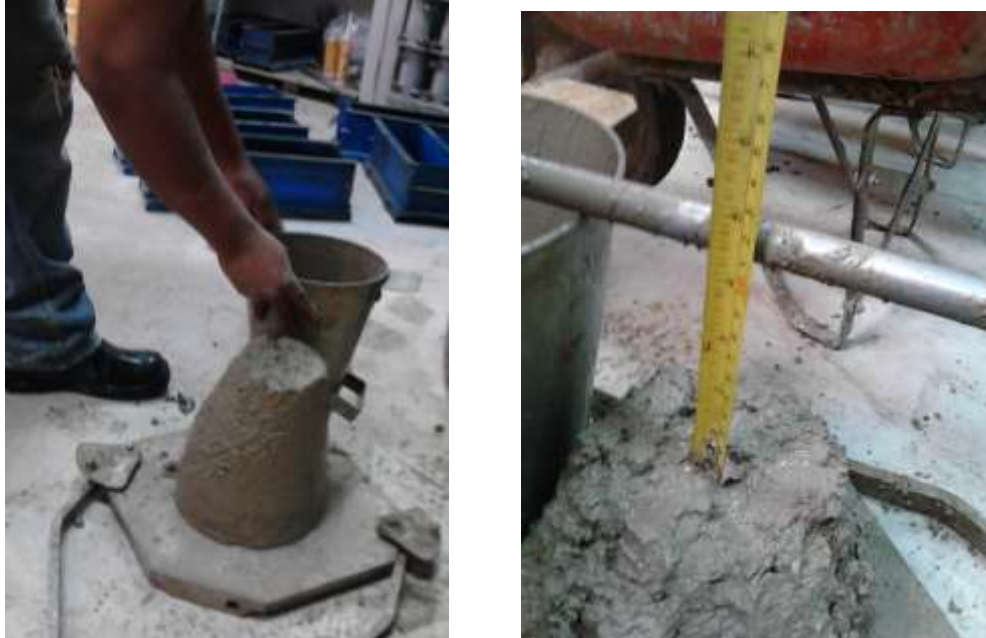
Figura 26. Prueba de asentamiento del concreto fresco
