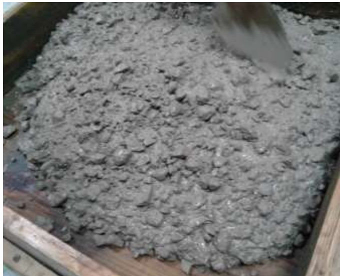
Figura 9. Mezcla de concreto
