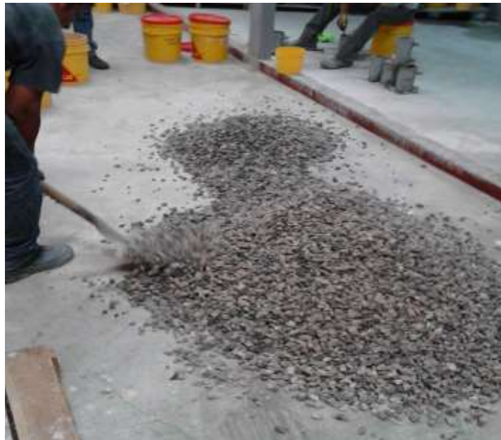
Figura 25. Proceso de homogenización del material
