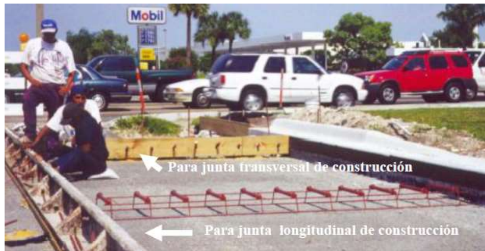
Figura 12. Juntas en proceso de construcción
