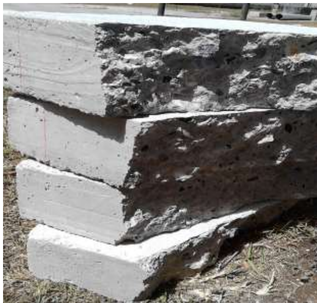
Figura 63. Efecto dovela en los agregados de la losa de 10 cm de espesor de concreto simple
