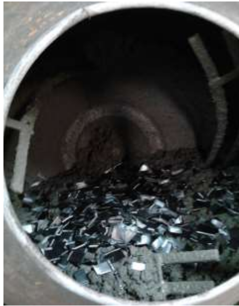
Figura 23. Adición de fibra metálica a la mezcla
