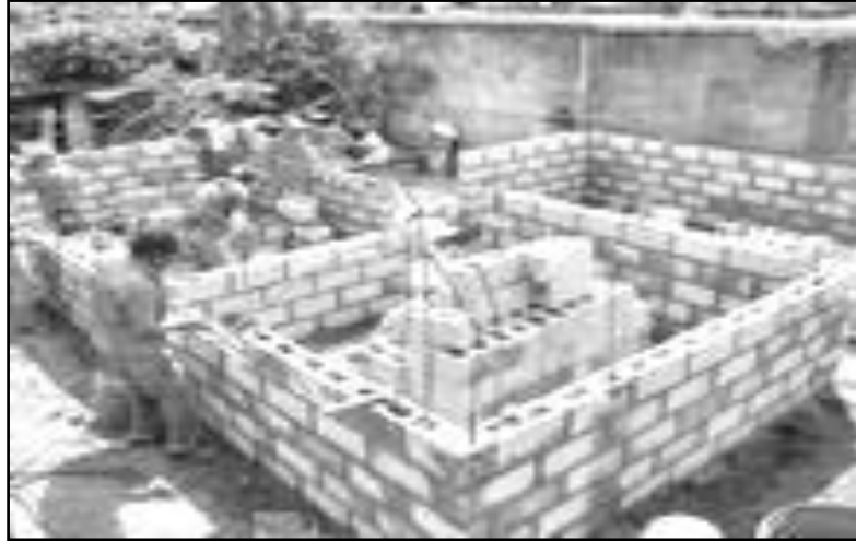
Figura 14. Construcción de mampostería sin refuerzo
