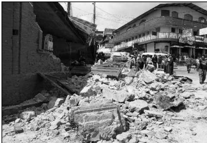
Figura 8. Daños en viviendas de adobe
