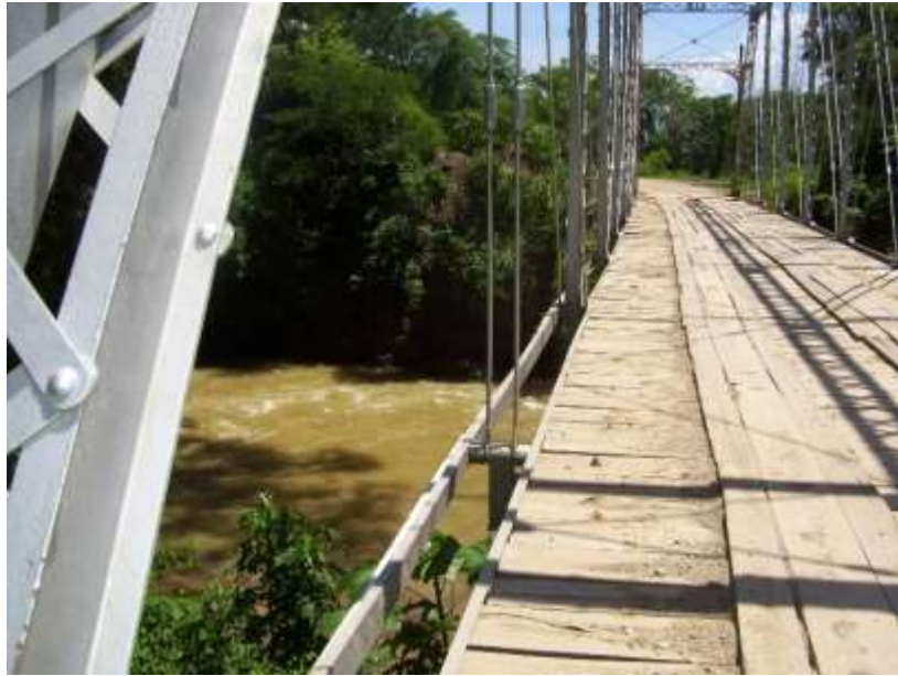
Figura 4. Superficie de rodadura de madera
