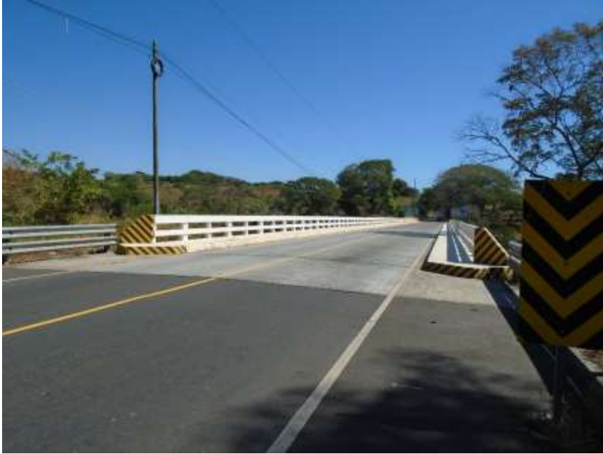
Figura 25. Losa de aproximación
