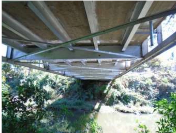
Figura 20. Vigas de acero 1
