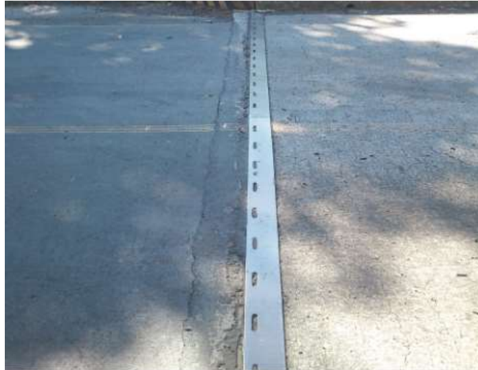
Figura 7. Junta estándar (acero reforzado)
