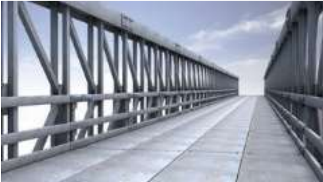
Figura 6. Superficie de rodadura de acero
