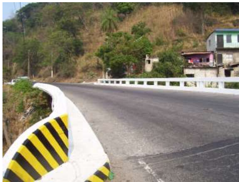
Figura 3. Superficie de rodadura de concreto asfáltico
