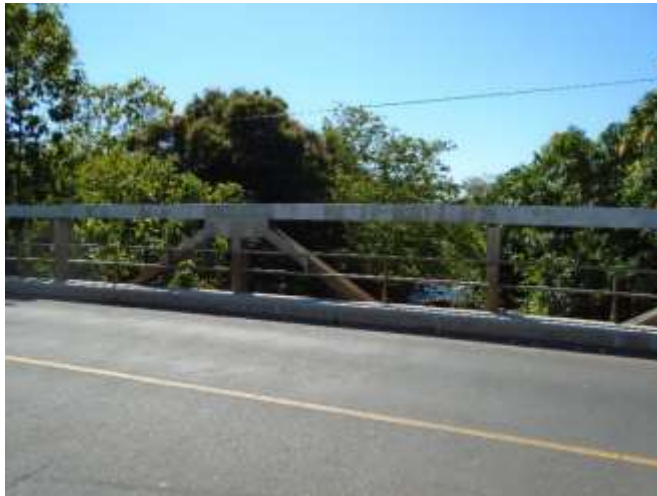
Figura 11. Barandal de acero estructural y galvanizado
