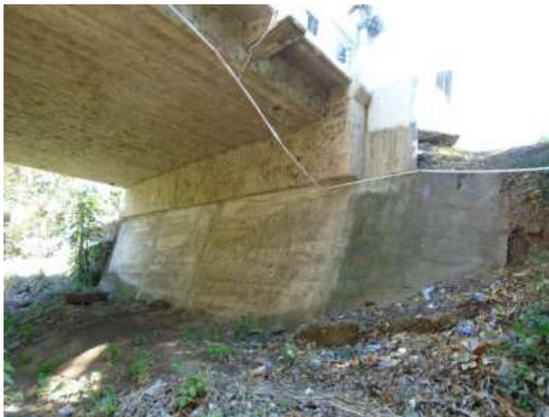
Figura 16. Losa de concreto armado
