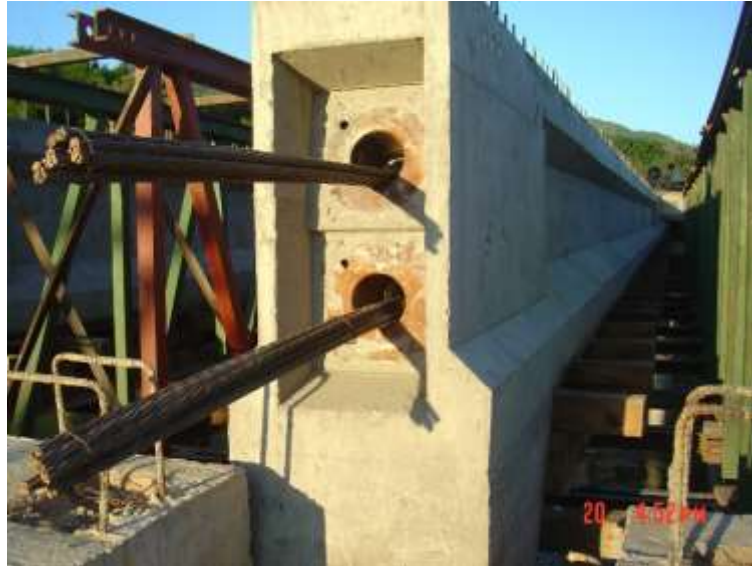
Figura 19. Viga de concreto postensado
