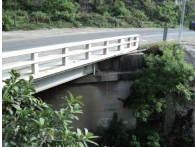
Figura 10. Barandal de concreto
