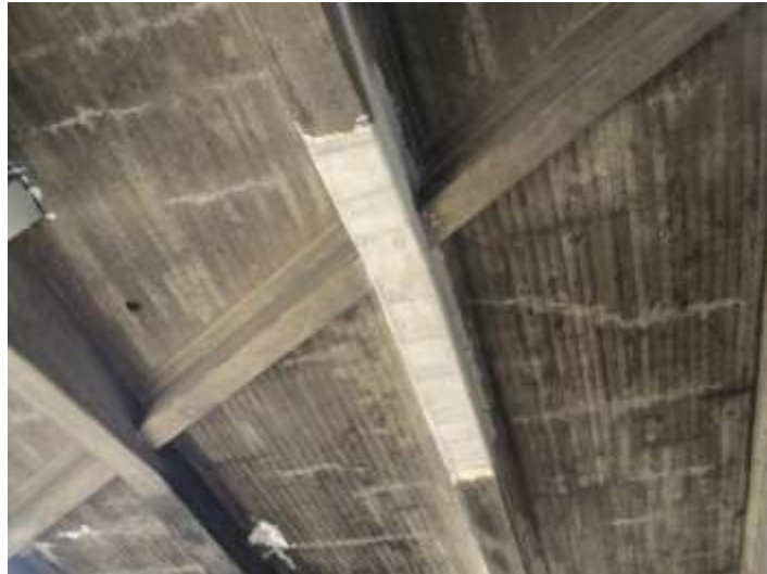
Figura 22. Viga de concreto reparada
