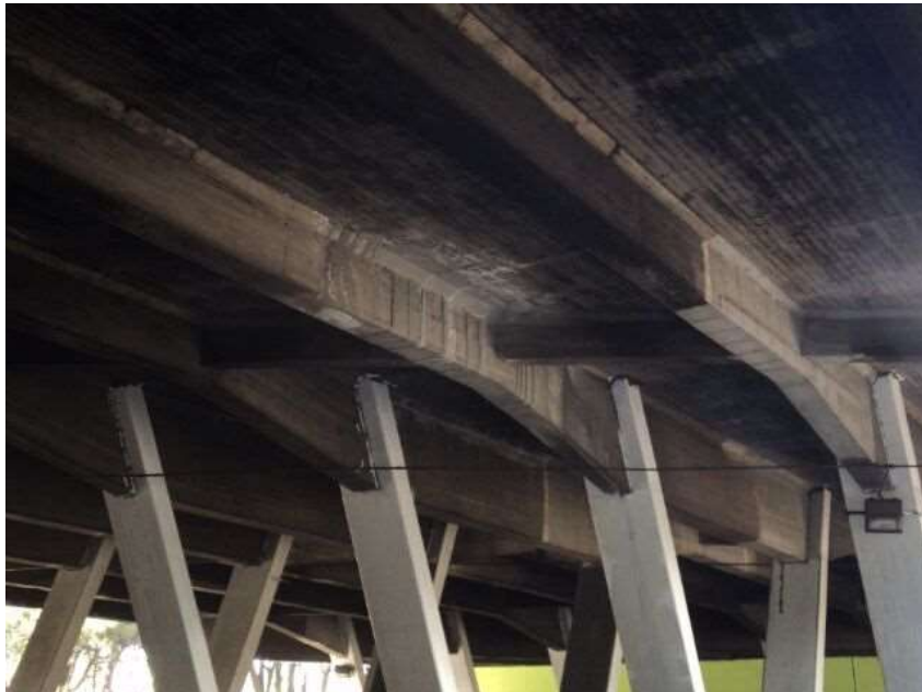
Figura 23. Vigas de concreto
