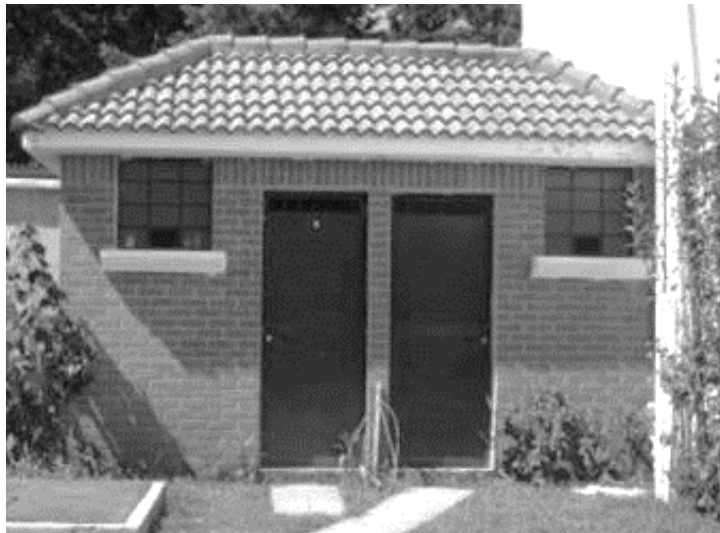
Figura 8. Caseta de control de bombeo
