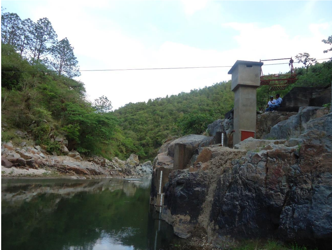
Figura 27. Vista aguas abajo estación hidrométrica
