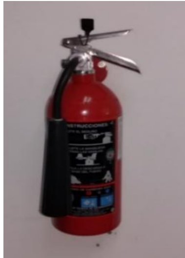
Figura 5. Extintor de dióxido de carbono (CO 2 ) para fuego BC
