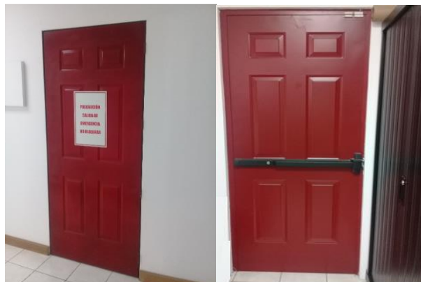
Figura 10. Puerta de emergencia
