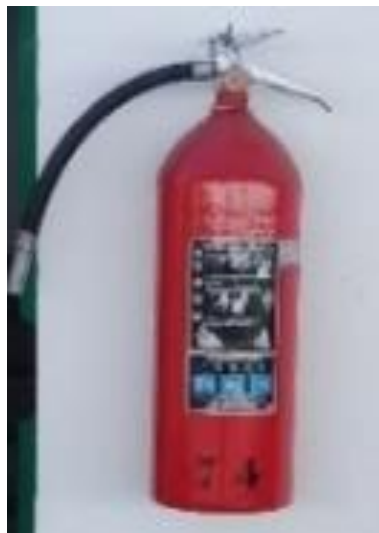
Figura 6. Extintor de polvo químico seco, para fuego ABC
