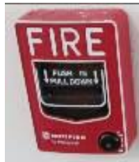
Figura 8. Botón de emergencia en data center
