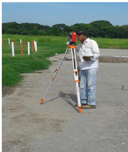
Figura 8. Trabajos de topografía en Escuintla, selva tropical
