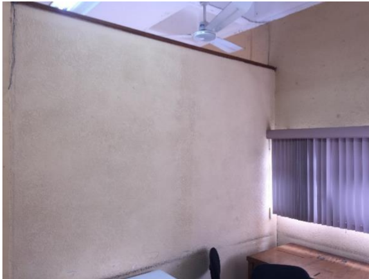
Figura 24. Ventiladores mal ubicados
