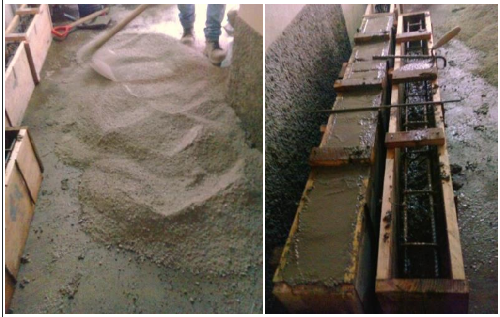
Figura 36. Fundición de vigas
