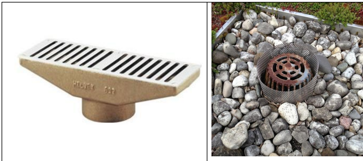
Figura 6. Tipos de rebosadero, para azoteas verdes
