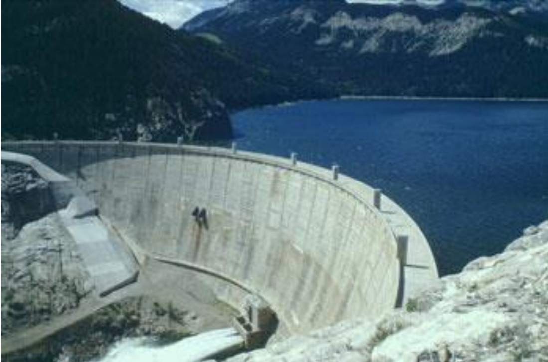
Figura 8. Presa tipo arco
