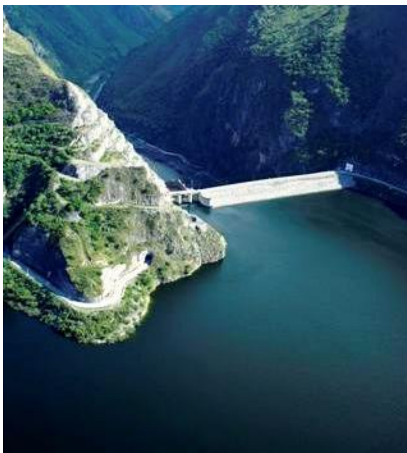
Figura 3. Hidroeléctrica con embalse
