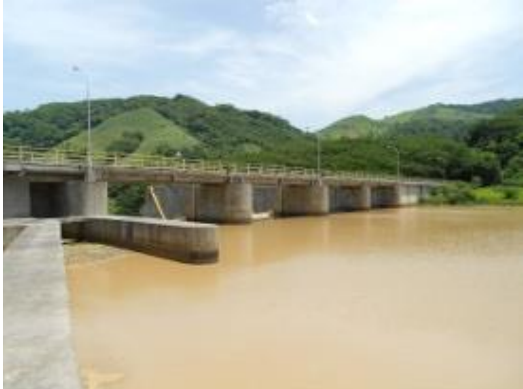
Figura 5. Presa de derivación hidroeléctrica Aguacapa
