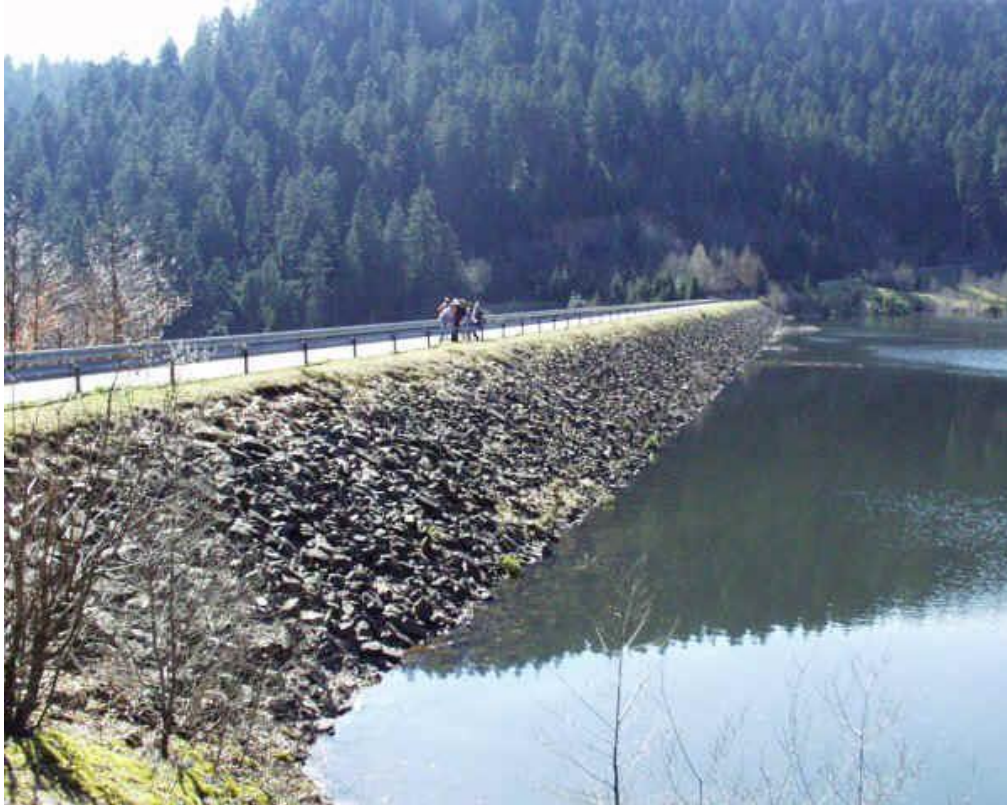
Figura 6. Presa de terraplén
