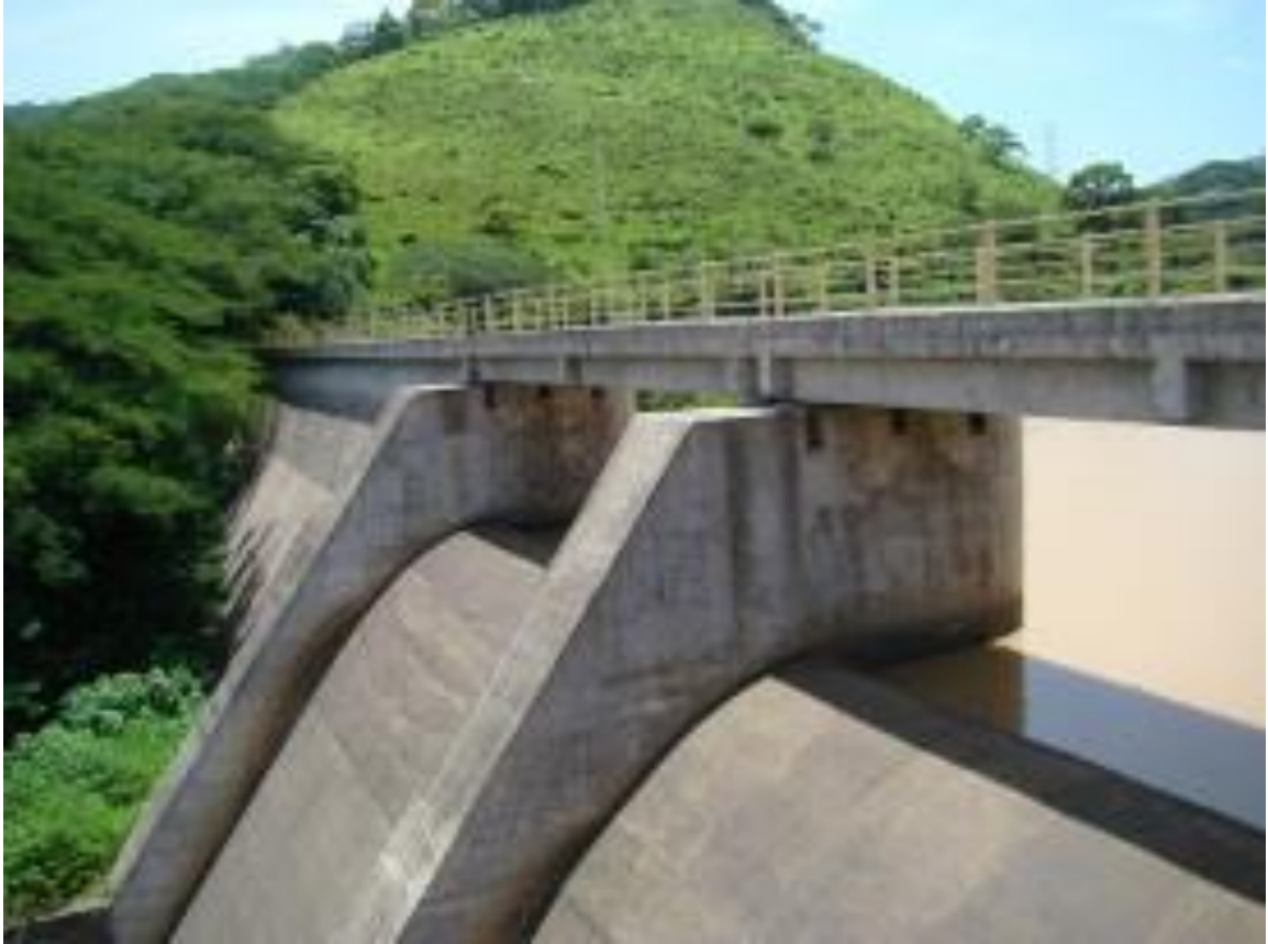
Figura 9. Presas de contrafuerte-hidroeléctrica Aguacapa
