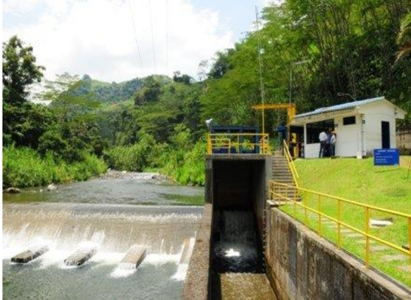
Figura 10. Bocatoma de una central hidroeléctrica
