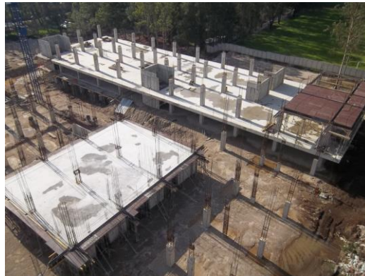
Figura 5. Construcción de hospital
