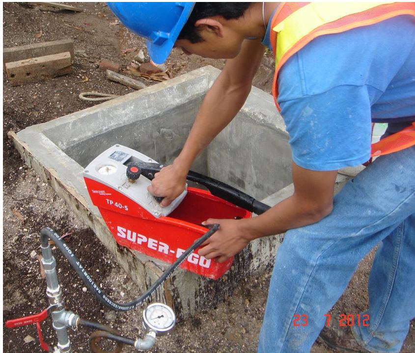
Figura 31. Prueba de presión en tubería de agua potable
