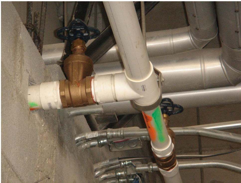
Figura 40. Intersección de instalaciones con diferente uso
