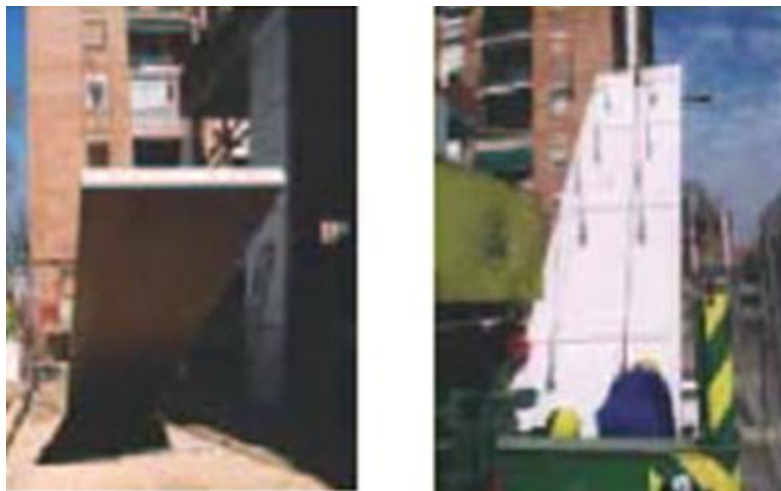
Figura 4. Proceso de posicionamiento de un panel de fachada
