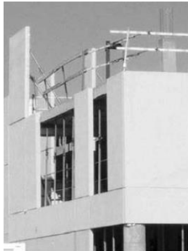
Figura 6. Proceso de anclaje de un panel de fachada
