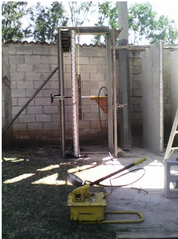
Figura 17. Ensayo por cargas transversales
