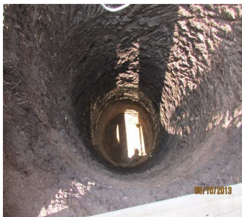
Figura 31. Proceso de excavación
