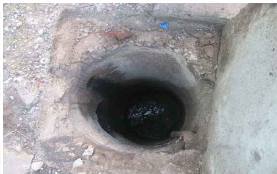
Figura 4. Foto conexión domiciliar
