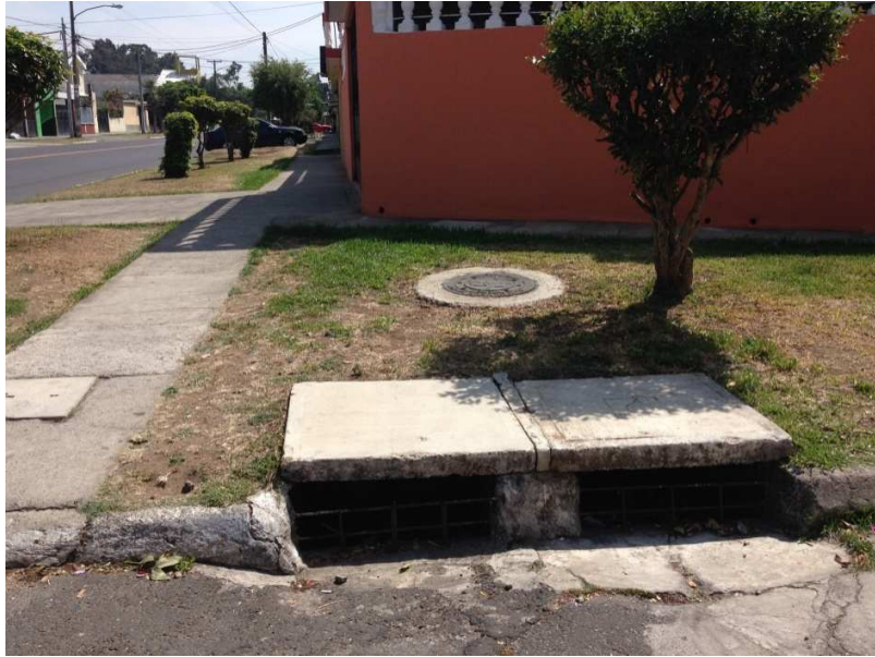
Figura 37. Lugar de trabajo terminado
