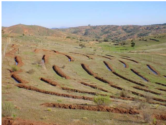
Figura 20. Zanjas de absorción
