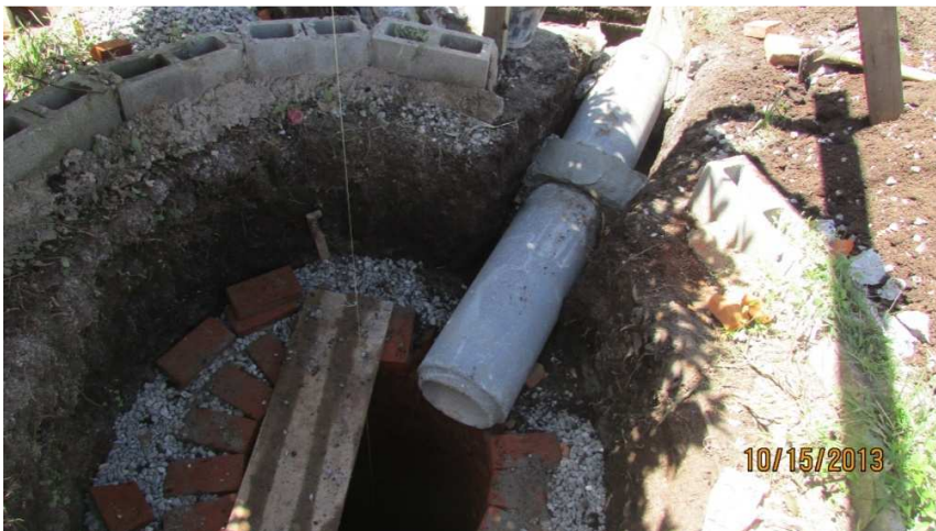
Figura 35. Conexión tragante pozo de absorción. Foto 2
