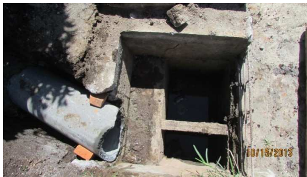
Figura 34. Conexión tragante pozo de absorción. Foto 1
