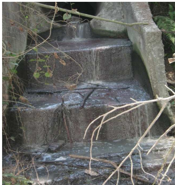
Figura 7. Foto disipador de energía
