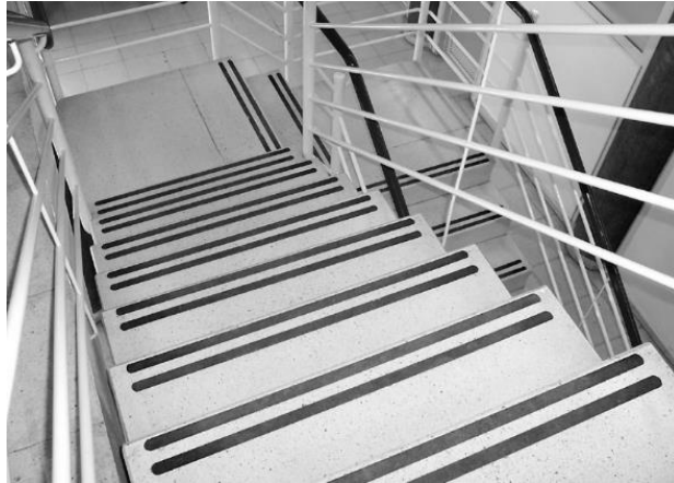
Figura 18. Escaleras con antideslizante
