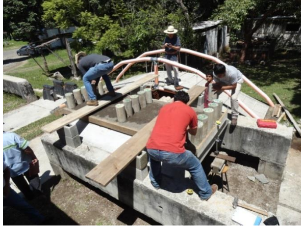
Figura 19. Colocación de cilindros de concreto
