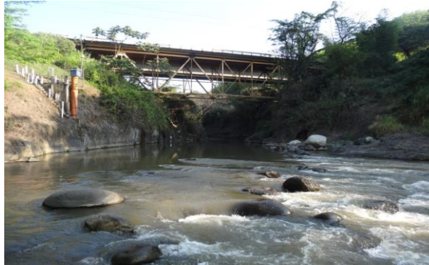
Figura 7. Estación puente Coyolate
