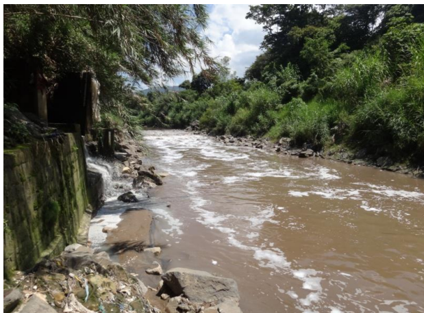
Figura 16. Estación Villa Canales
