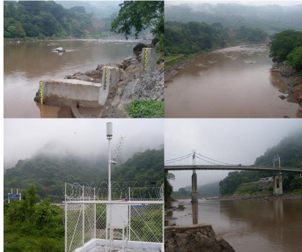
Figura 19. Estación El Jobo
