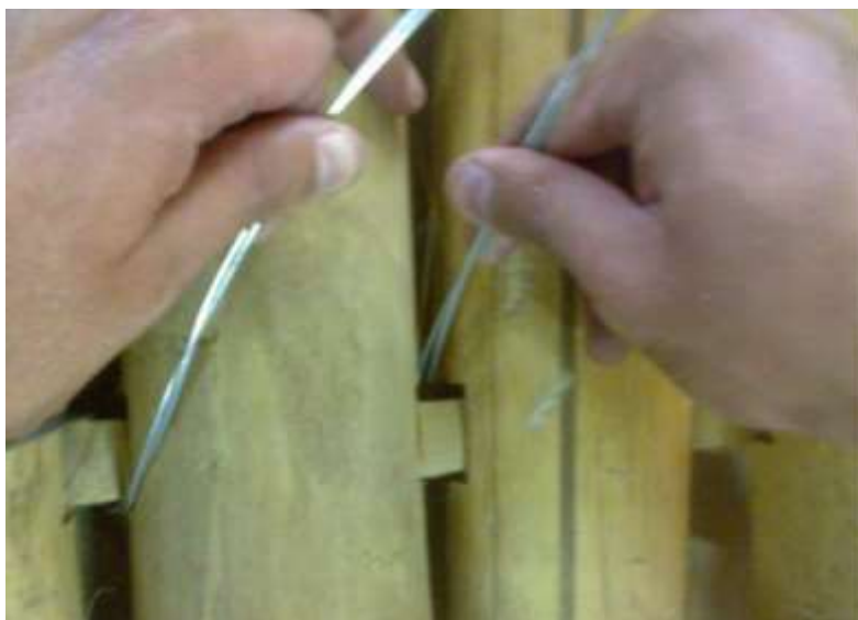
Figura 60. Sujeción de caña de bambu con el pasador por medio de entretejido con alambre galvanizado
