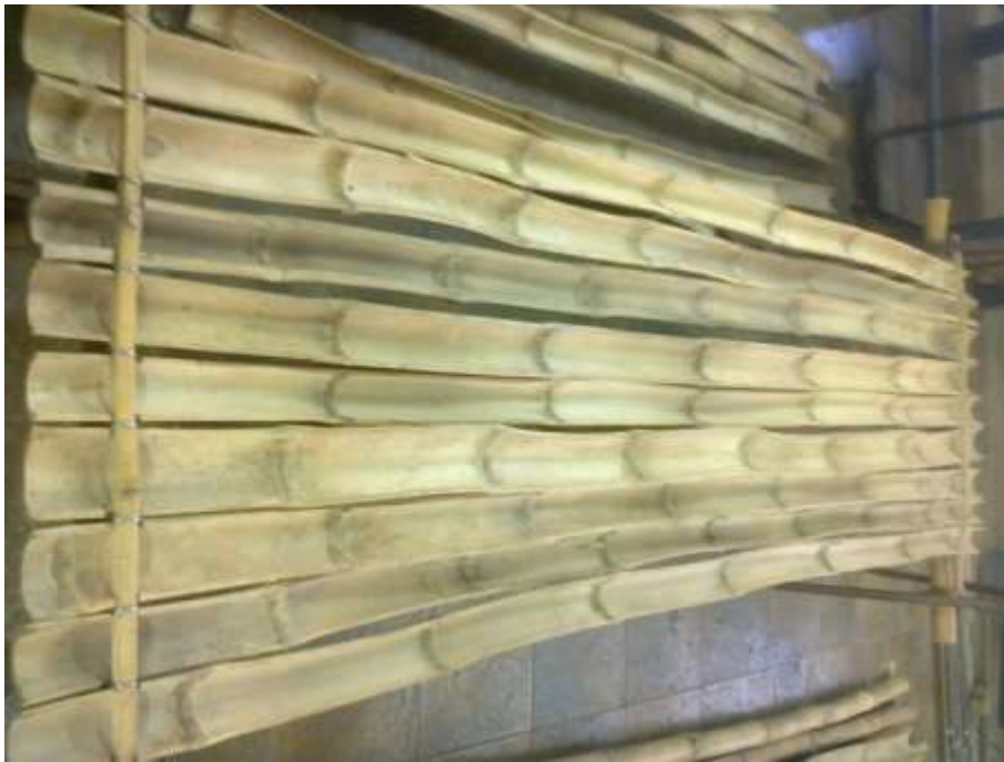
Figura 10. Armado de cañas de bambú con concavidad hacia arriba
