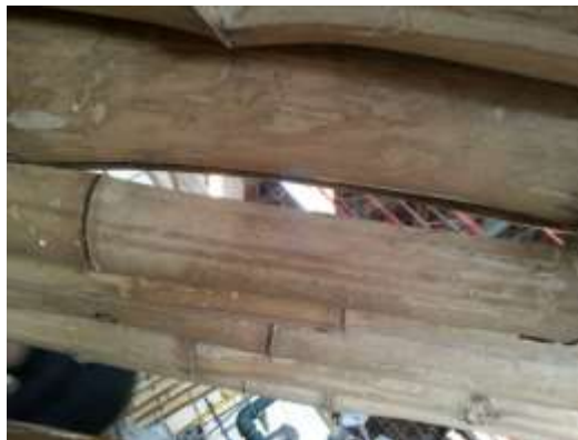
Figura 29. Abertura por curvatura de la caña de bambú
