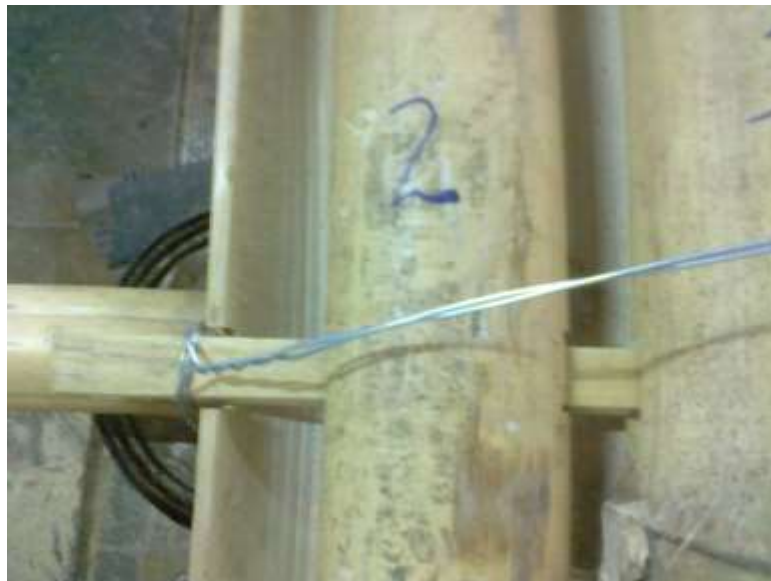
Figura 59. Sujeción de alambre galvanizado en uno de los extremos del pasador
