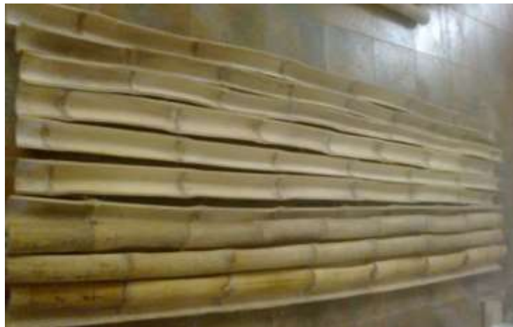
Figura 56. Ensamblado de cañas de bambú
