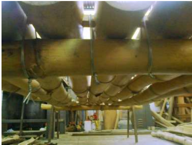
Figura 8. Sujeción a estructura de soporte de cubierta de techo
