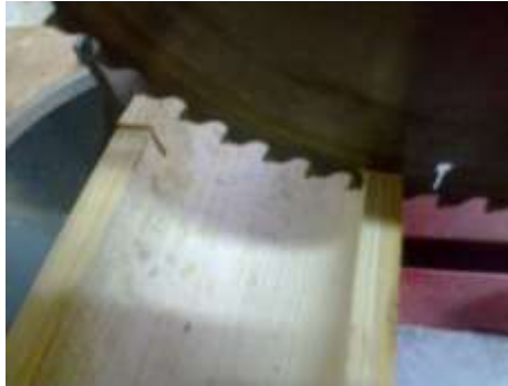
Figura 47. Corte para elaboración de muescas de pasador con maquina ingletadora
