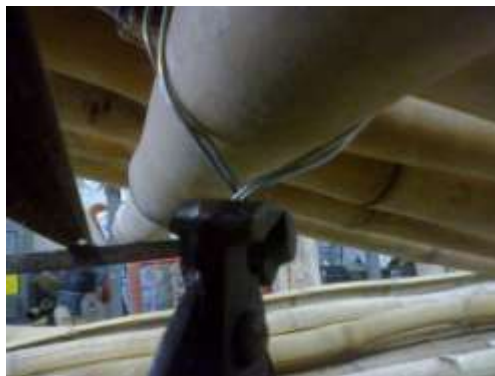
Figura 54. Fijación de anclaje
