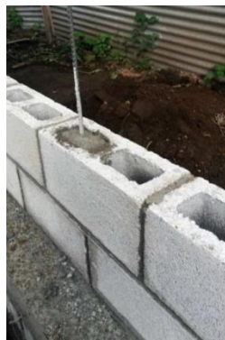
Figura 5. Mampostería reforzada con pines
