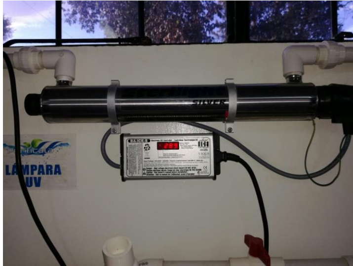
Figura 19. Filtrado con lámpara UV
