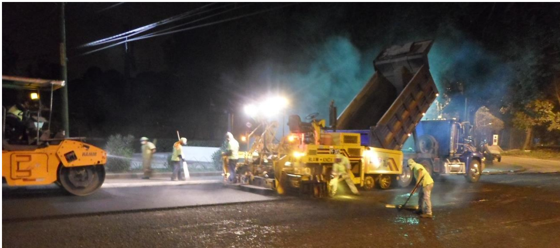
Figura 54. Operación de descarga en la terminadora de asfalto
