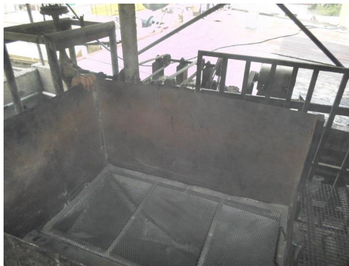
Figura 29. Tolva de recepción del co polímero con malla incluida
