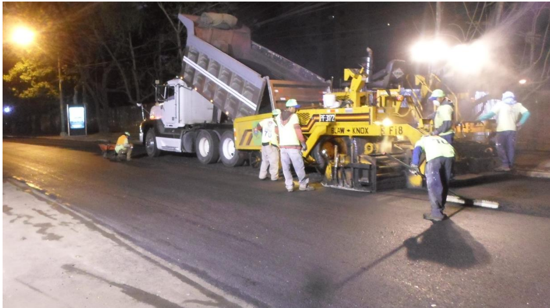
Figura 58. Colocación de asfalto y trabajo del rastrillero en la junta
