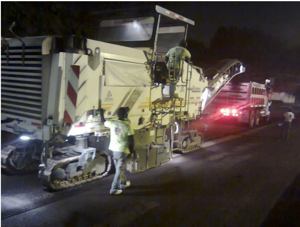
Figura 46. Perfiladora de asfalto y vehículo de transporte
