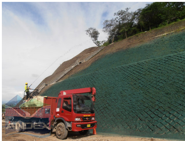
Figura 37. Hidrosiembra aplicada a taludes de banquetas con protección contra la erosión
