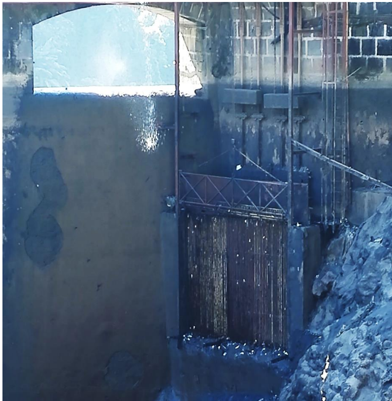
Figura 4. Fotografía de Bocatoma
