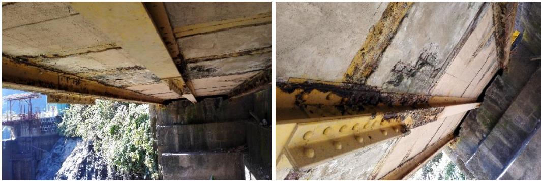
Figura 7. Vista inferior de la sección puente-canal del canal auxiliar
