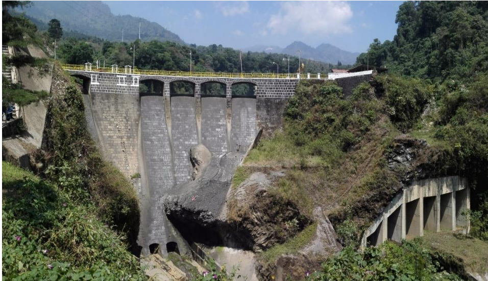
Figura 1. Fotografía de la presa vista aguas abajo
