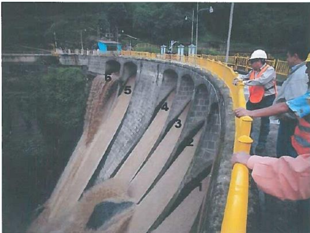
Figura 29. Vista de la presa y sus seis vertederos
