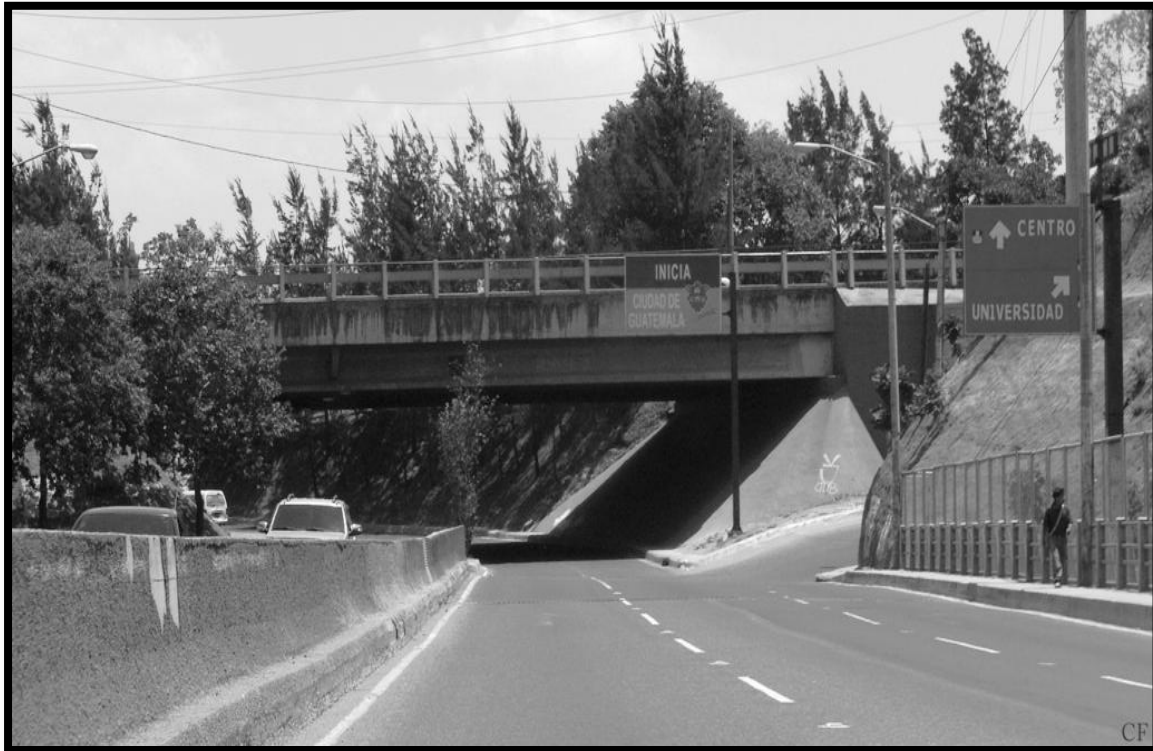
Figura 20. Puente Periférico-Naranjo, municipio de Guatemala, departamento de Guatemala
