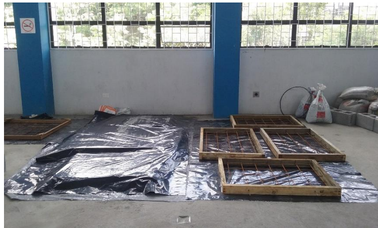
Figura 34. Curado de paneles y formaletas con su armado para la segunda fundición
