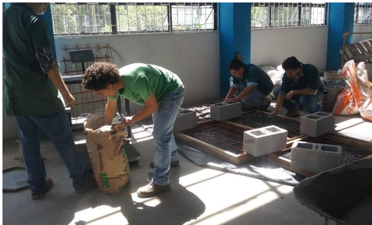
Figura 33. Fundición de paneles de concreto
