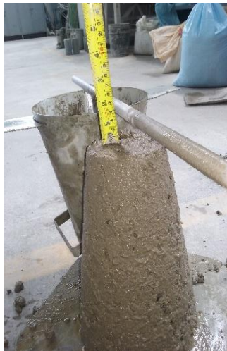
Figura 12. Prueba de asentamiento para el concreto
