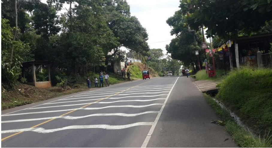
Figura 50. Estado del tramo 2 en la estación 194+200
