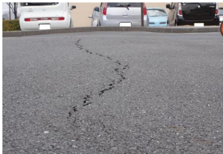
Figura 10. Hinchamiento severidad alta
