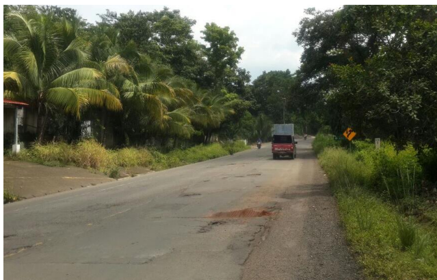
Figura 49. Estado del tramo 1 en la estación 186+000
