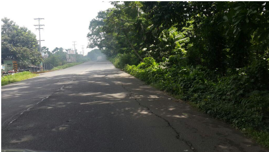
Figura 51. Estado del tramo 3 en la estación 218+700
