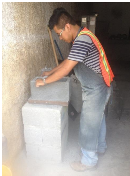
Figura 20. Nivelación de bloques de concreto
