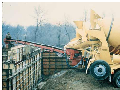
Figura 42. Banda transportadora montada sobre camión mezclador
