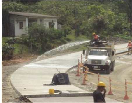
Figura 54. Curado mediante aspersores
