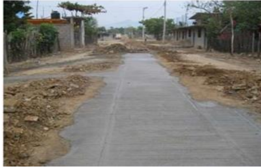
Figura 51. Curado con cubiertas húmedas
