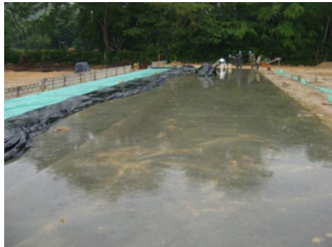
Figura 50. Curado con agua
