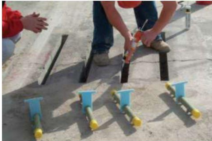
Figura 50. Sistema de colocación de dovelas
