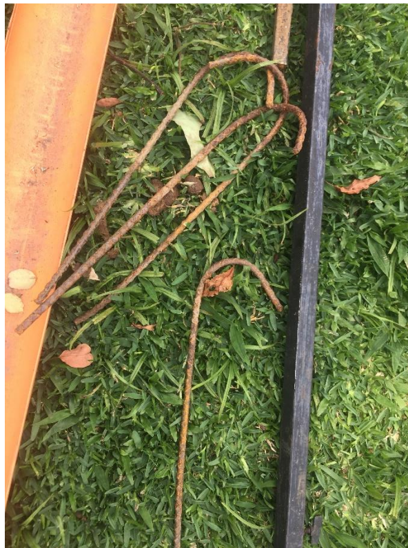
Figura 25. Vista de los anclajes utilizados
