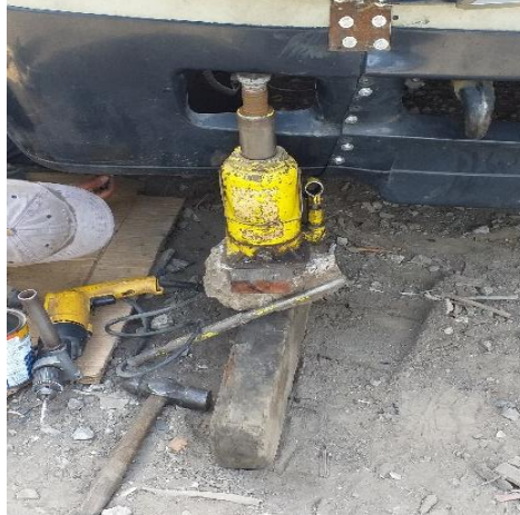
Figura 6. Acciones inseguras en el levantamiento de cabezales
