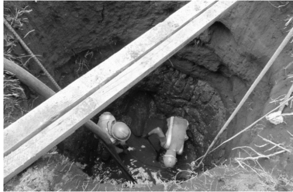
Figura 10. Excavación para cimentación de estructura de soporte donde se encontró el nivel freático
