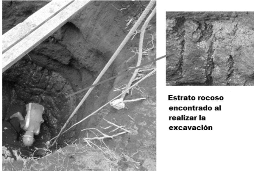
Figura 15. Excavación en roca
