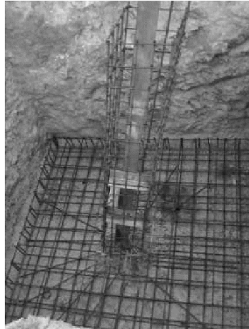
Figura 9. Ejemplo de armado de cimentación para una de las patas de la torre de transmisión eléctrica
