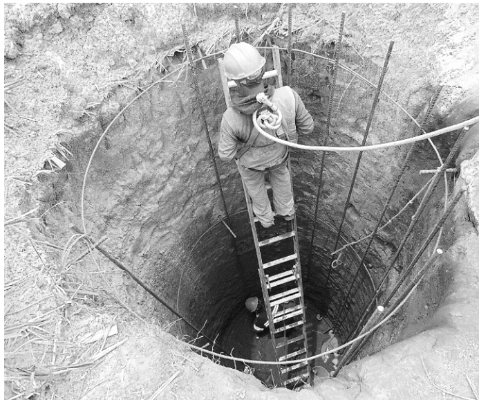
Figura 16. Colocación de refuerzo de cimentación dentro de excavación
