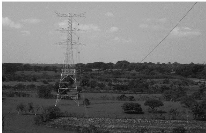
Figura 2. Torre de transmisión eléctrica
