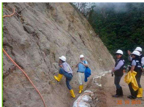
Figura 13. Talud en condiciones iniciales
