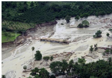
Figura 4. Puente Jones, Teculután, Zacapa
