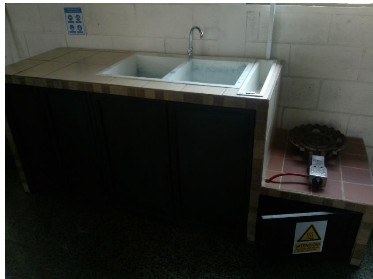
Figura 31. Estación de trabajo terminada
