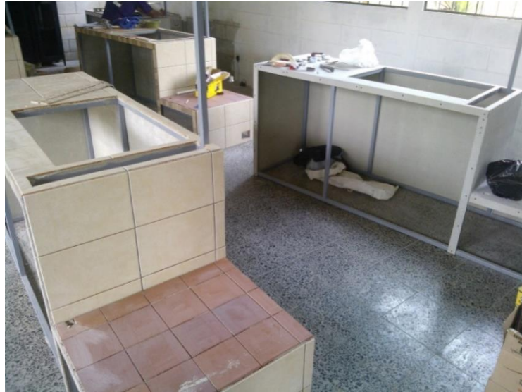
Figura 30. Estación de trabajo en construcción II
