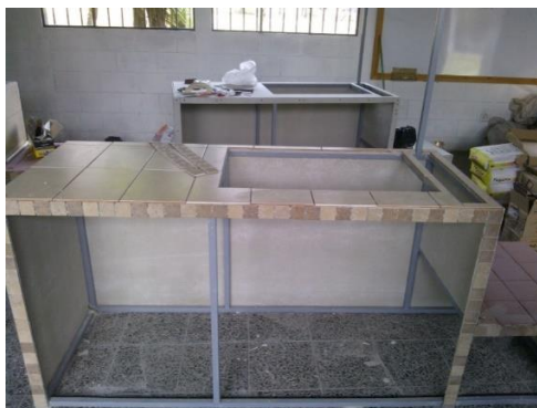
Figura 29. Estación de trabajo en construcción I
