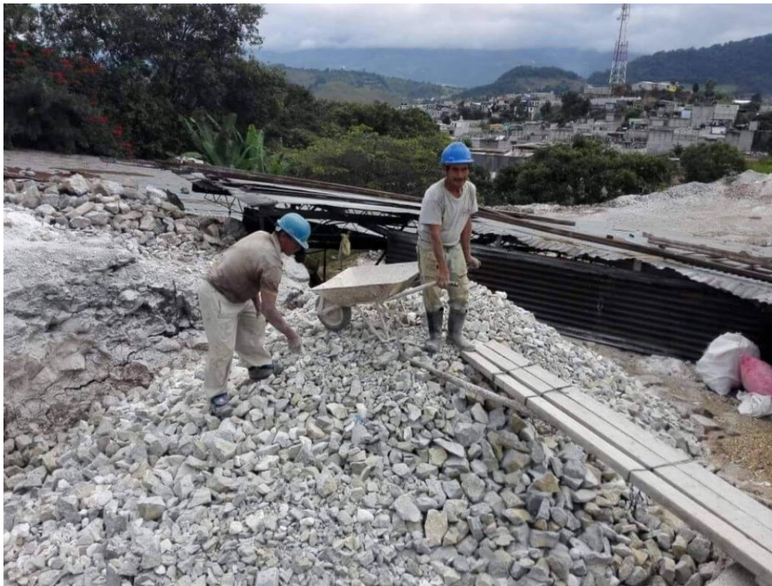
Figura 32. Colocación de materia prima
