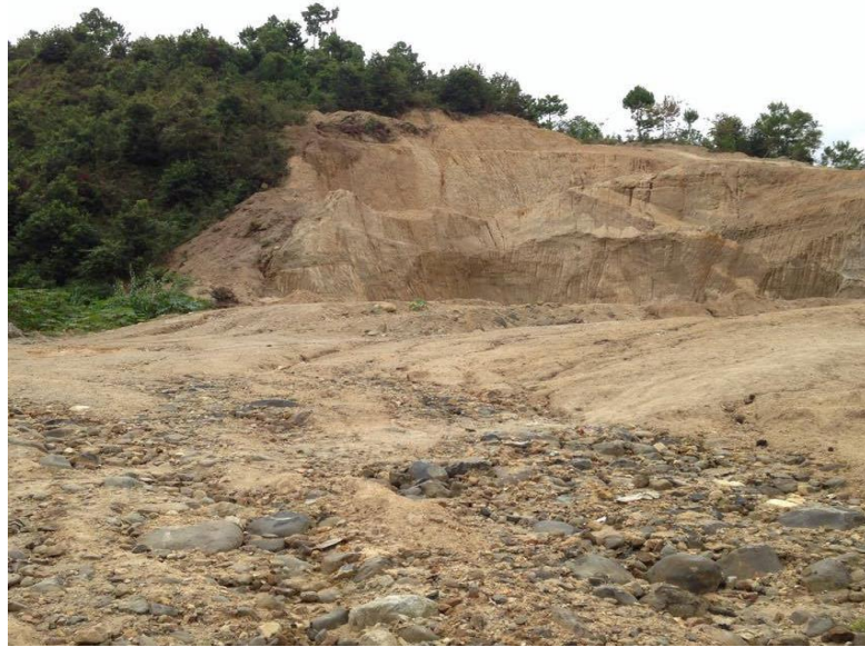
Figura 9. Situación actual del tramo final de carretera
