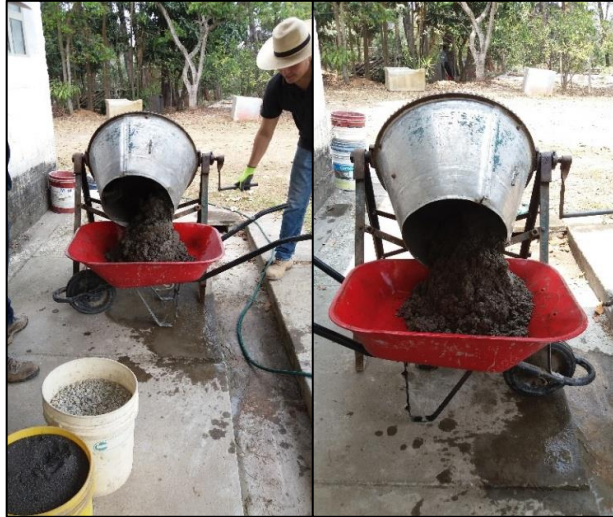
Figura 37. Mezclado del hormigón
