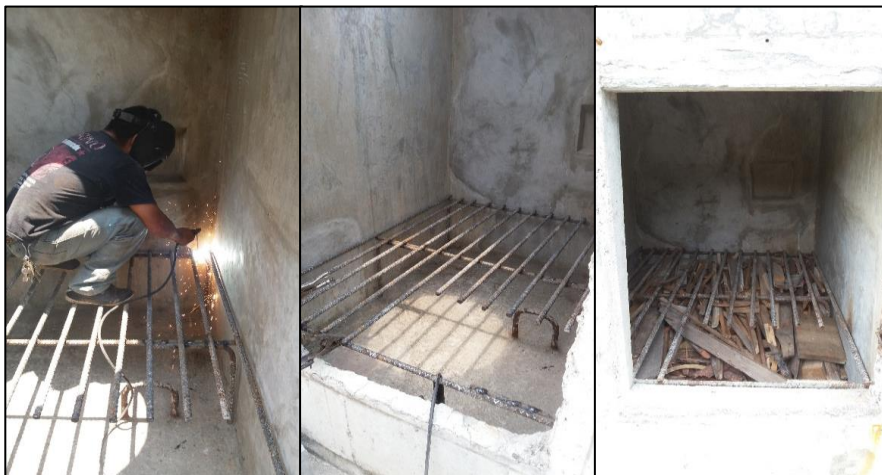
Figura 42. Rejilla de barras de acero
