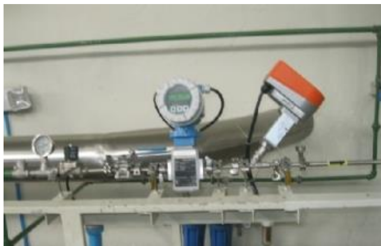
Figura 20. PLC para control de flujo de agua
